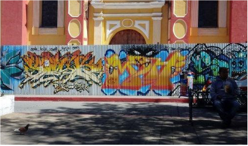
Protección a la Catedral de San Cristóbal para la reconstrucción de los agravios hechos por el sismo en 2017. La estructura sirvió de tela para el arte del graffiti. Fotografía: Aline de Moura Rodrigues, abril de 2019.
