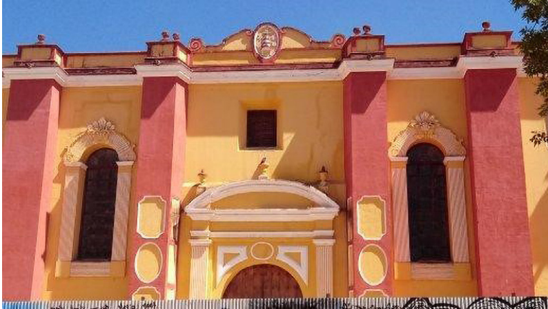
Catedral de San Cristóbal 93 . Primeras fotos sacadas en San Cristóbal de Las Casas. Fotografía: Aline de Moura Rodrigues, 2019.
